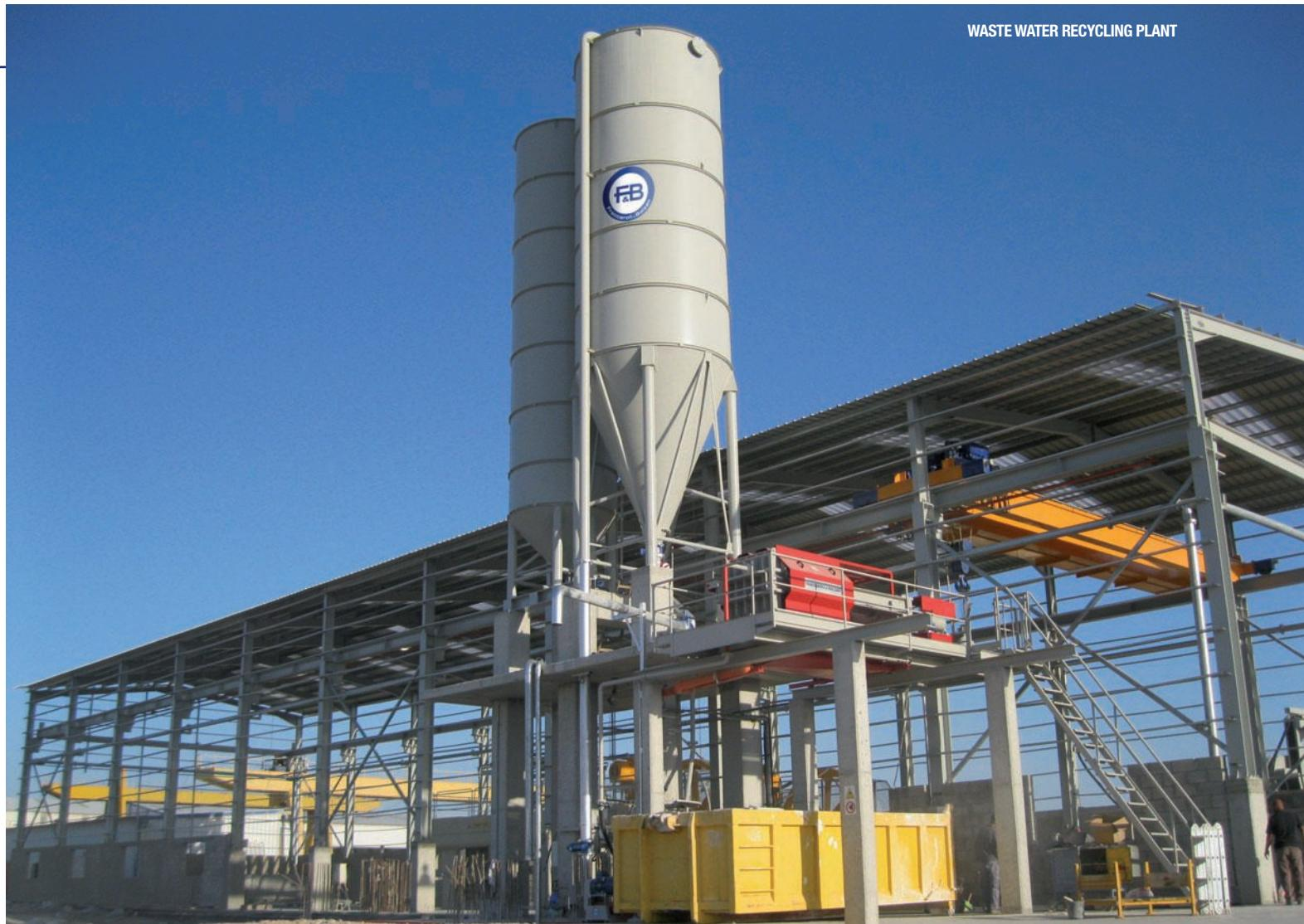
reflue raccolte da due telai, completo di decantatore, contenitore di stoccaggio delle acque decantate ed unità di rilancio delle acque pulite alle utenze dei telai.
